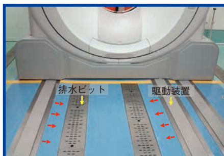
図 2 排水ピットに向けてつけられた 10mm の勾配
