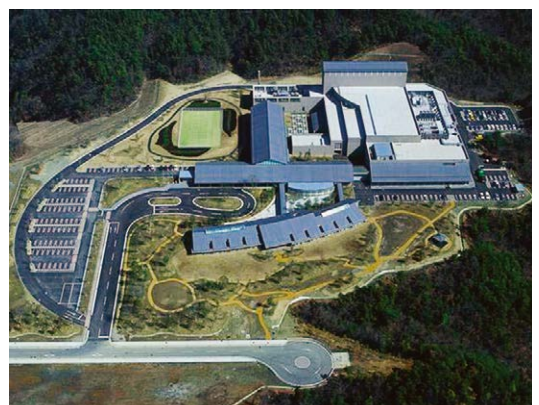
図2 上空から見た兵庫県立粒子線医療センター
