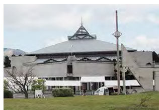
国立京都国際会館・イベントホール
